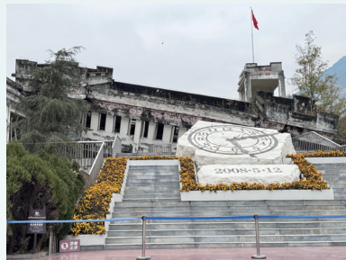
在地震中倒塌的教學大樓
